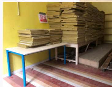
Stockage des dalles de faux-plafonds pour réemploi
