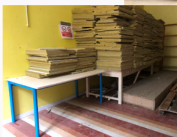
Stockage des dalles de faux-plafonds pour réemploi
