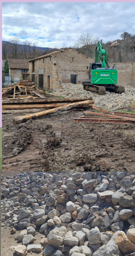
Dépose des pierres par JMTP
