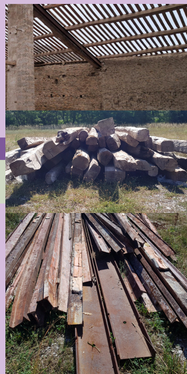
Dépose de la charpente bois et IPN (JMTP)
