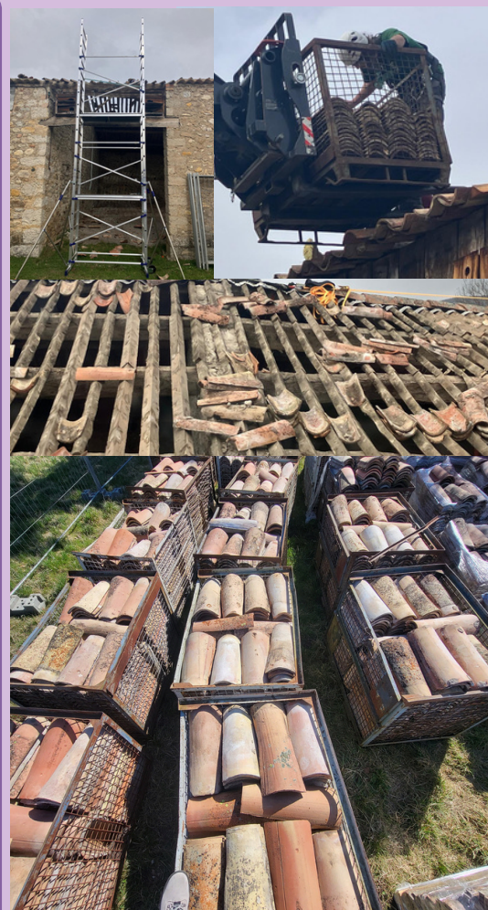
Dépose des tuiles par La Mine du réemploi
